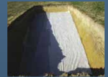
GEOTEXTILVERLEGUNG
